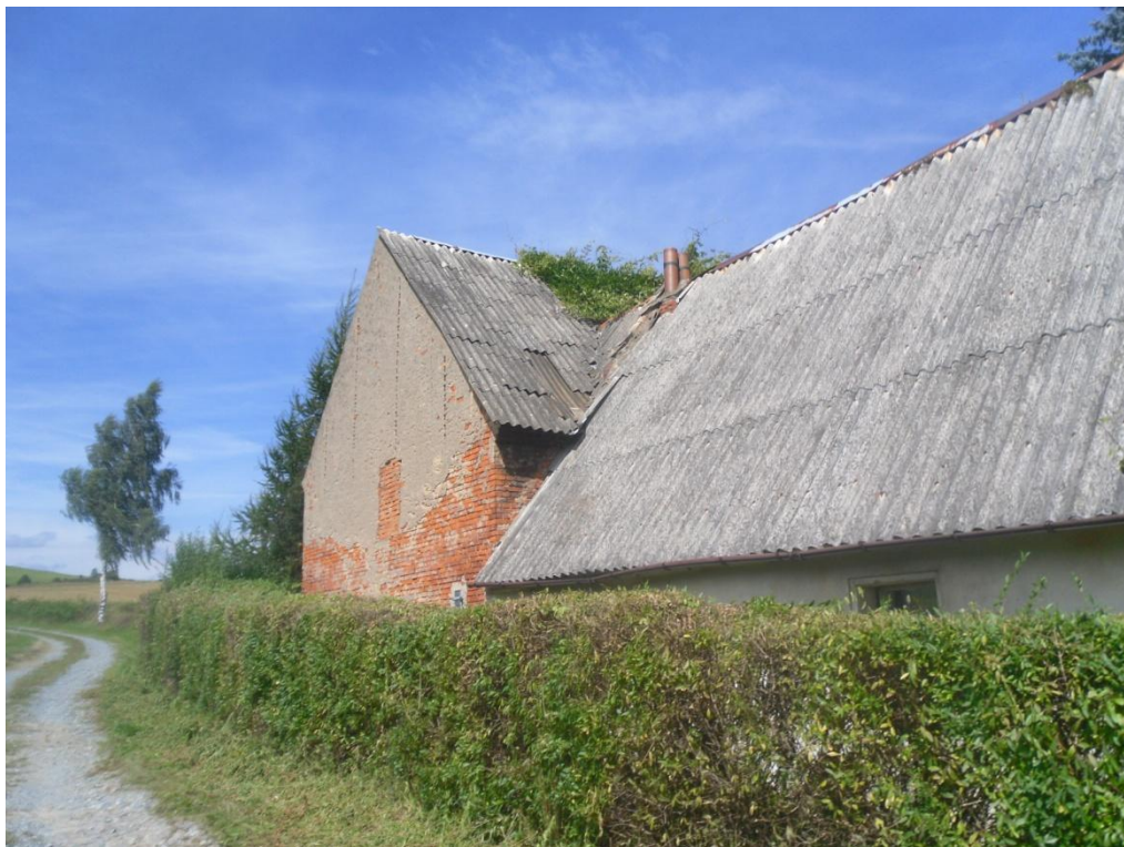
Fot. 1 Budynek gospodarczy z wyraźnie uszkodzonymi płytami azbestowymi w miejscowości Opolnica.
