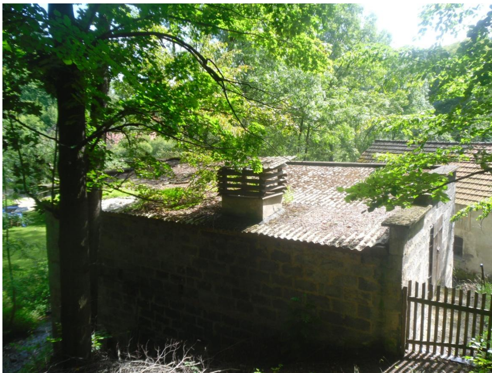
Fot. 4 Budynek pokryty azbestem, który nie figuruje na mapach geodezyjnych.
