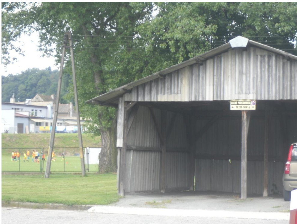
Fot. 5. Wiata garażowa z płyt azbestowych na terenie nieruchomości obok przychodni zdrowia i w pobliżu boiska, w miejscowości Bardo.
