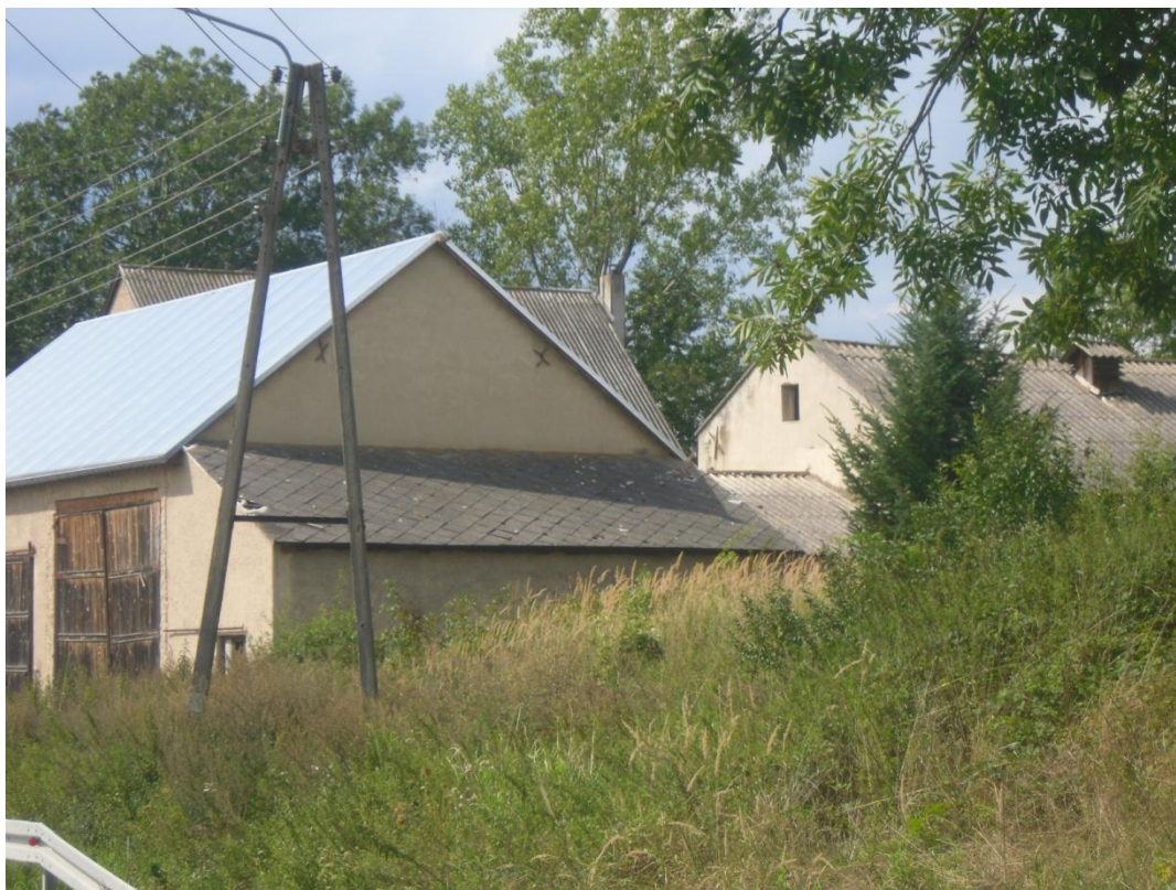
Fot. 2 Różne budynki gospodarcze (stodoła, gospodarczy, wiata) pokryte płytami azbestowymi. Potworów.
