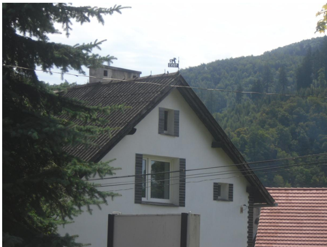
Fot. 6. Wykonane z płyt azbestowych pokrycie dachu w budynku mieszkalnym (Bardo)
