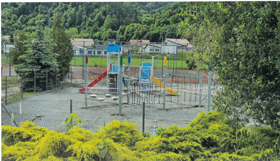
Fot. 15 Modernizacja placu zabaw przy szkole
