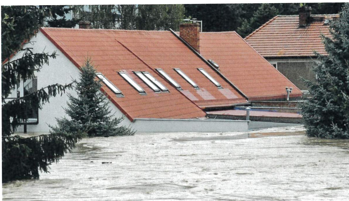
Fot. 17 Zniszczona siedziba Ośrodka Pomocy Społecznej w Bardzie
