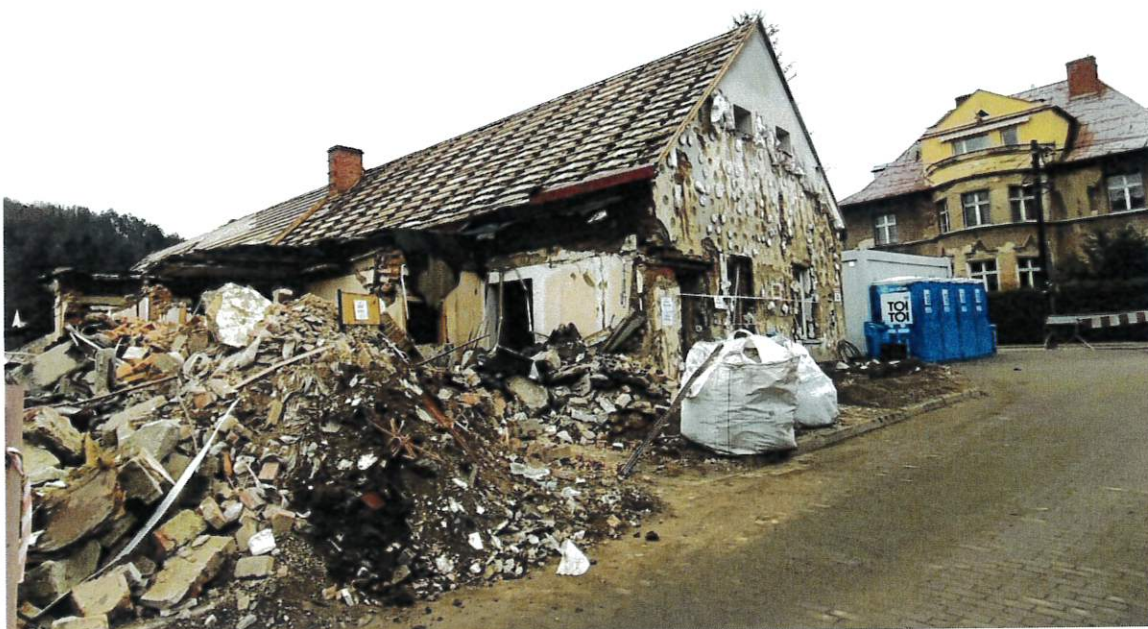
Fot. 16 Zniszczona siedziba Ośrodka Pomocy Społecznej w Bardzie
