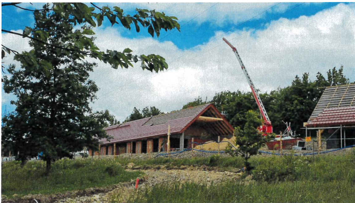
Fot. 4 Budowa Centrum Turystyki Rowerowej
