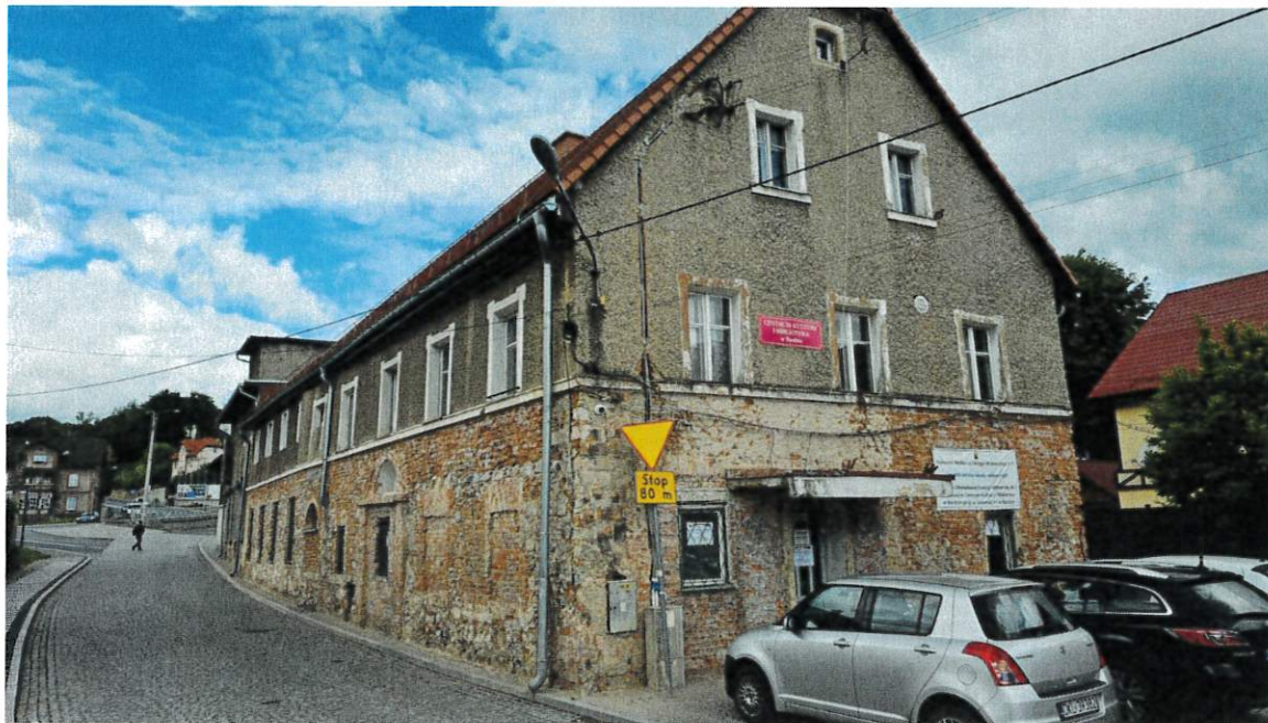
Fot. 10 Odbudowa budynku CKiB
