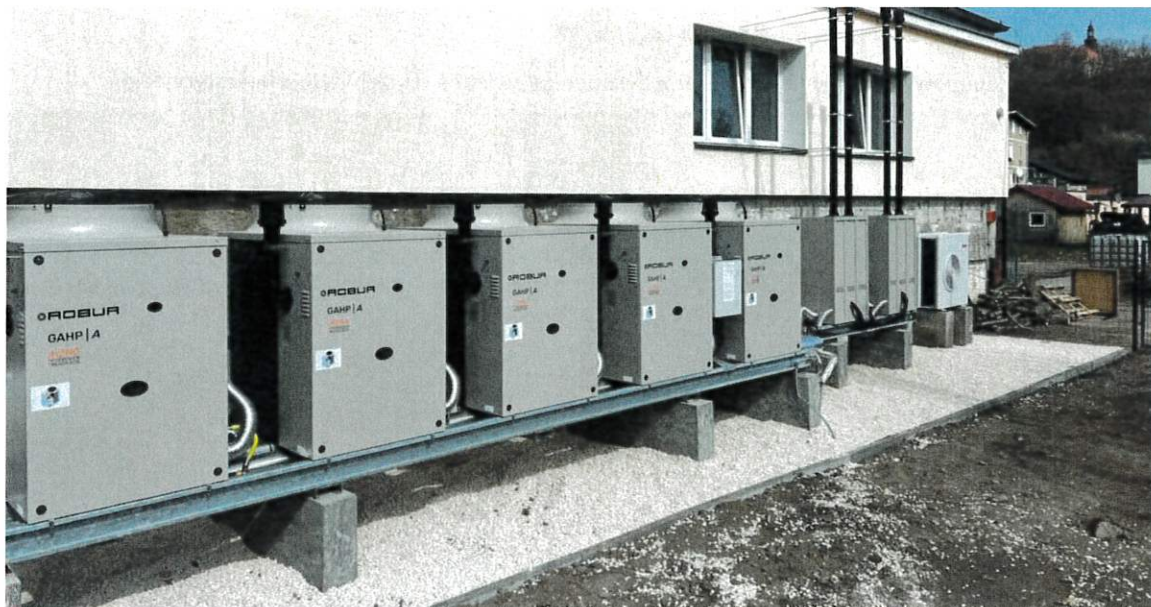
Fot. 6 Odbudowa budynku ZSP - kotłownia
