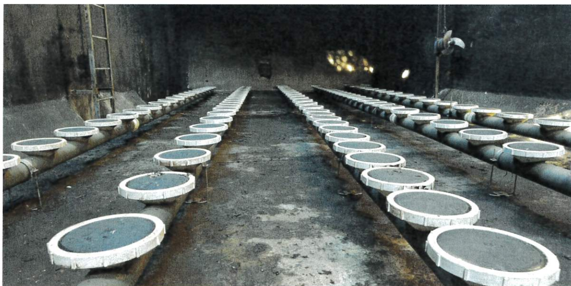
Fot. 7 Modernizacja oczyszczalni ścieków
