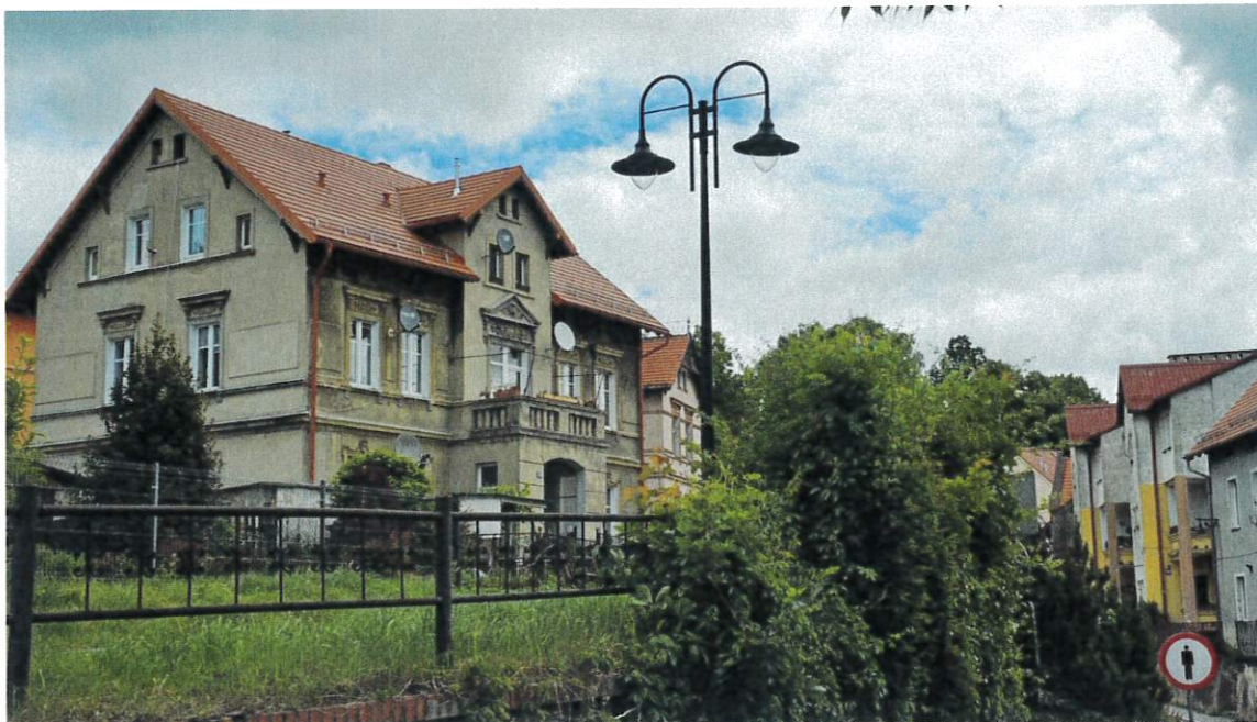
Fot. 8 Oświetlenie uliczne w Bardzie
